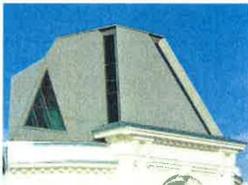
Le dôme a été réalisé avec un revêtement métallique à double agrafes d'entraxe de 530 mm en zinc-titane prépatiné, 0.8 mm d'épaisseur.
